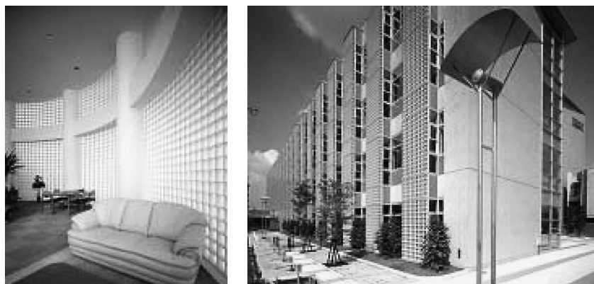
ガラスブロックの施工例
