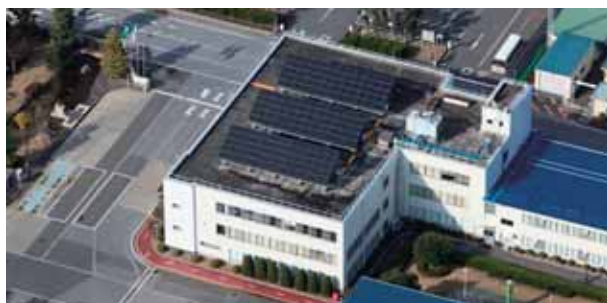
事務棟屋上における太陽光発電風景
