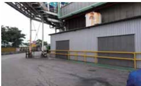
コンプレッサー室への防音壁設置
