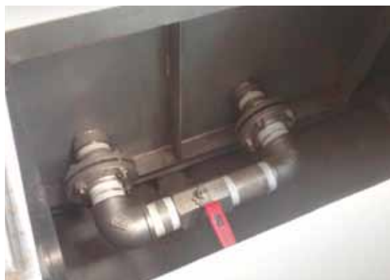
タンク二重底部分
