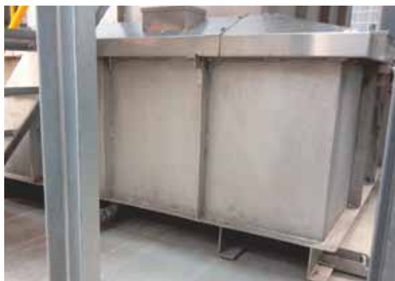
架空状態で設置
