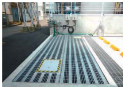
外部から見た埋設ピット
