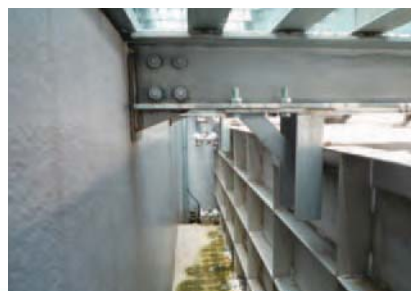
地下部分にステンレスの枡を設置
