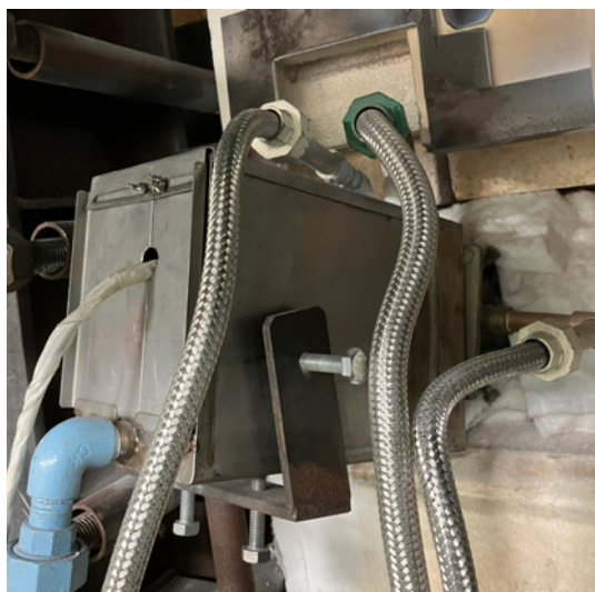
ITV装置の取り付け
