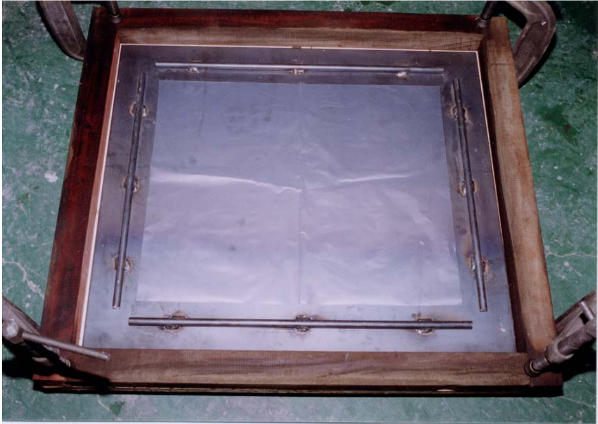
写真1 拘束用鉄板を設置した型枠
