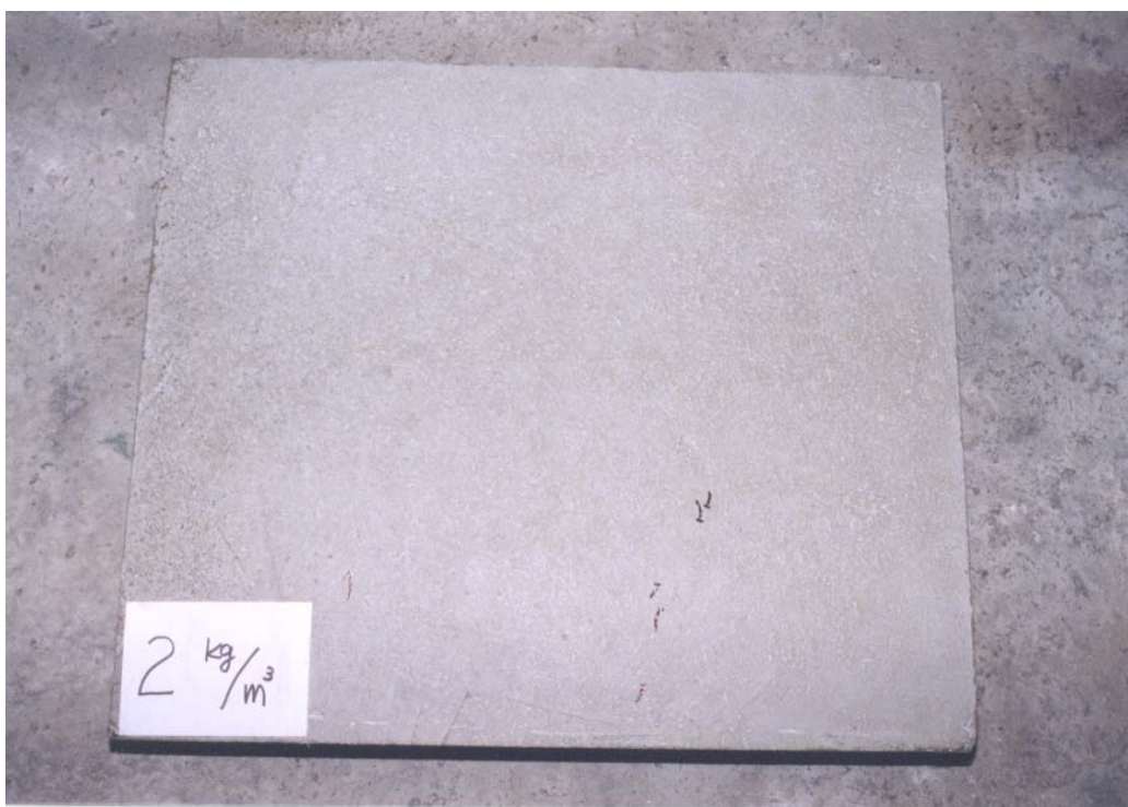
写真5 クラックの発生状況 (No. 4, 2.0 kg/m 3 )
